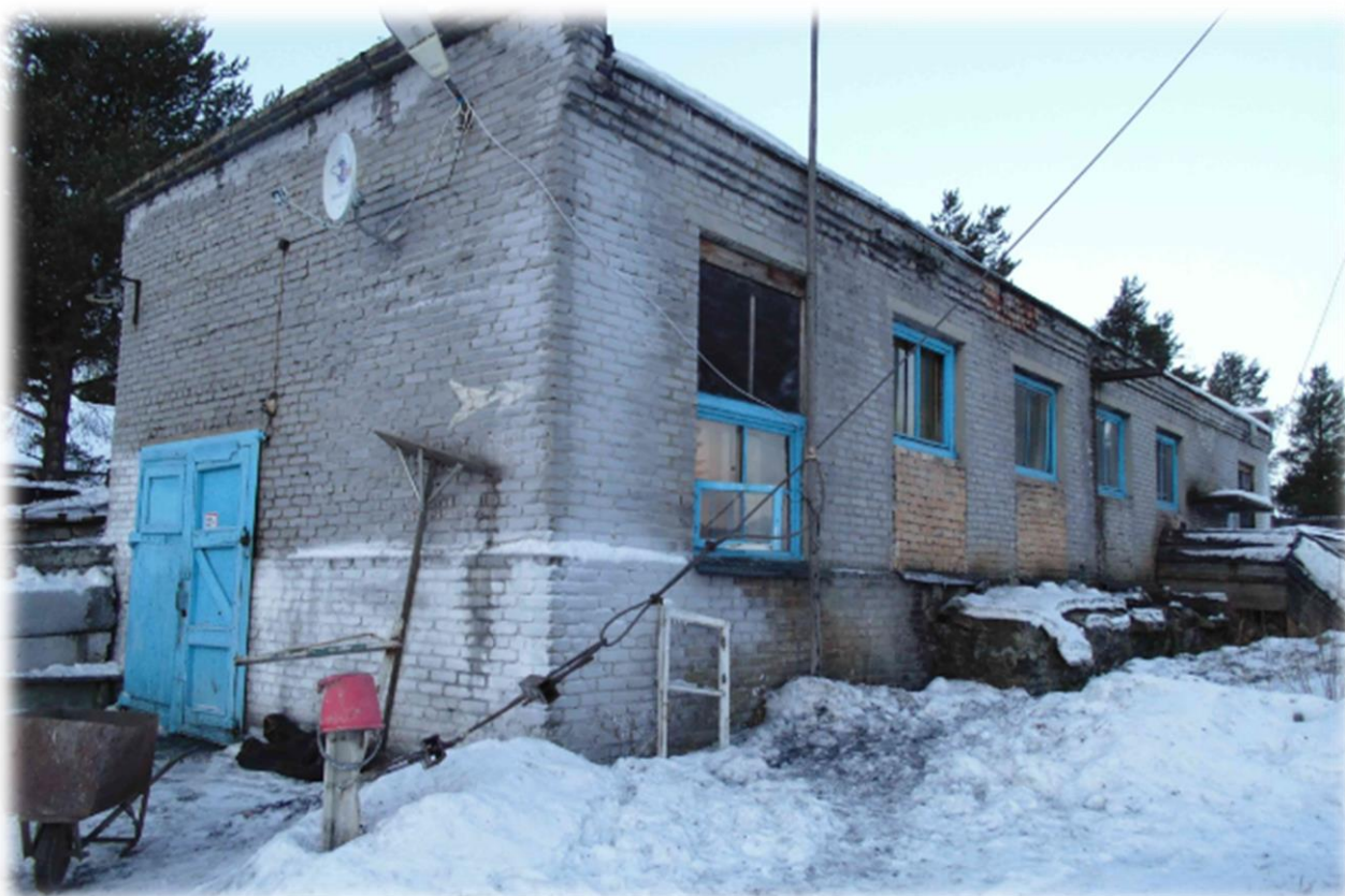
Рисунок 5. Котельная ст. Чупа.
