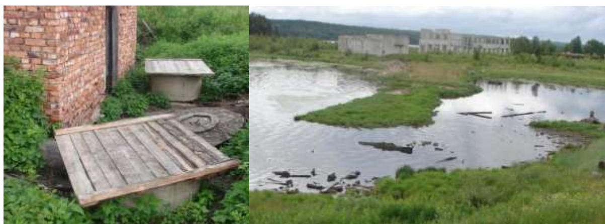
Рис. 3.1 Очистные сооружения п.г.т. Чупа
