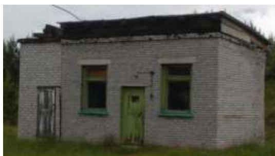
Рис. 2.8 Здание насосной станции II подъема
